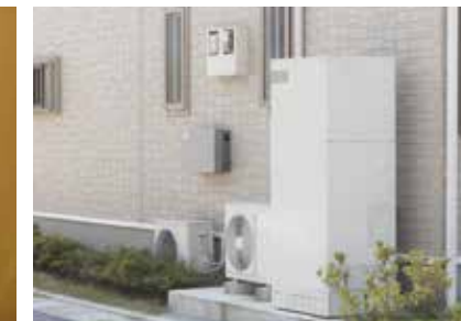
▲ 施工事例⑥
