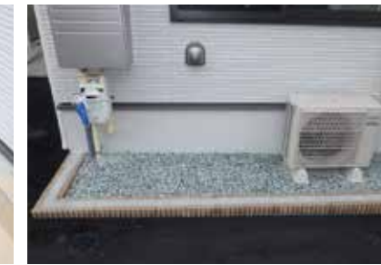
▲ 施工事例③
