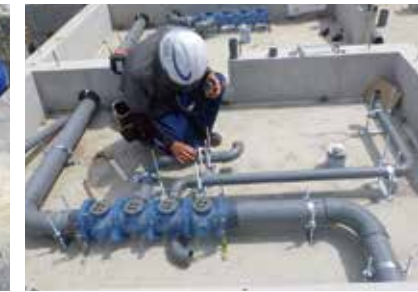
▲ 工事風景②
