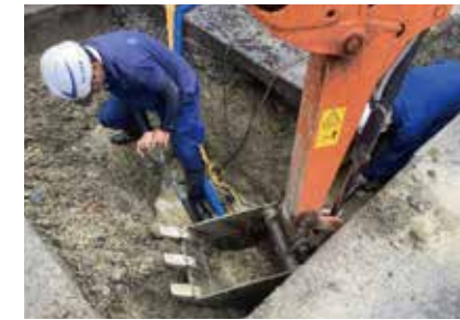
▲ 工事風景①
