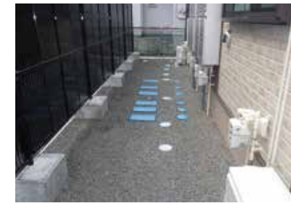
▲ 施工事例①
