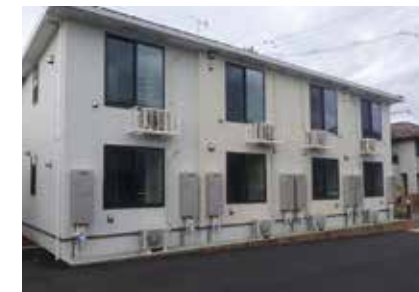
▲ 施工事例④
