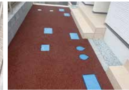
▲ 施工事例②
